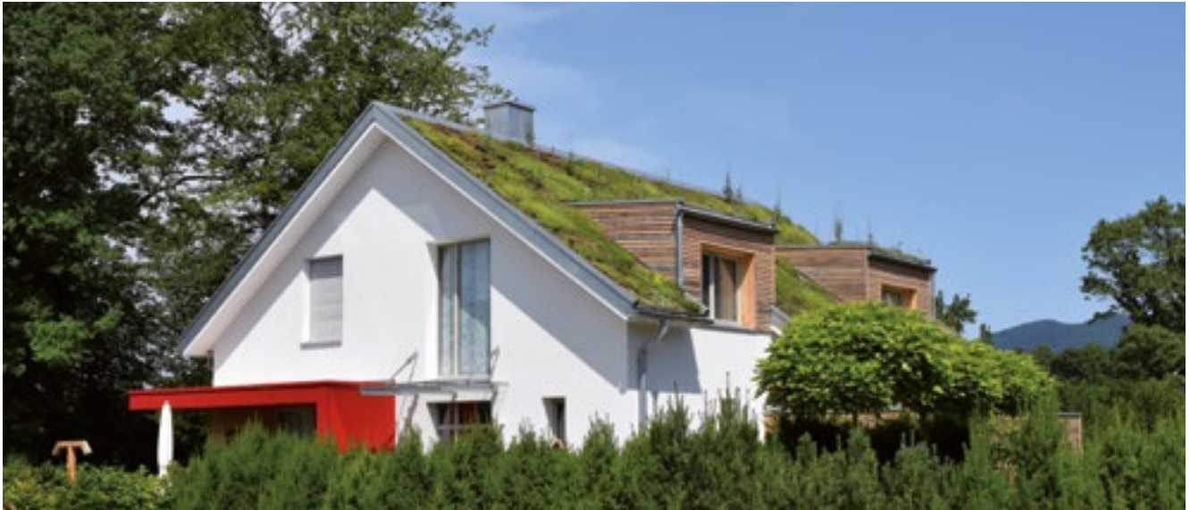
18 Begrünung eines Schrägdaches
