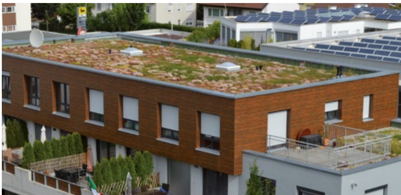
17 Dachfläche mit Extensivbegrünung
