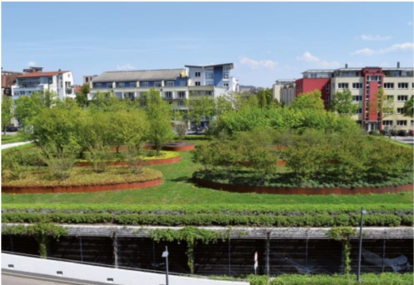
15 Intensivbegrünung einer Tiefgarage
