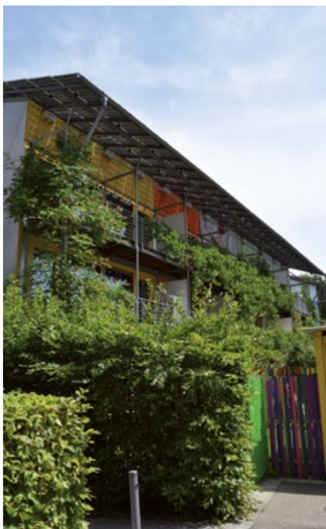
30 Beispiel einer Fassadenbegrünung an einem Wohngebäude
