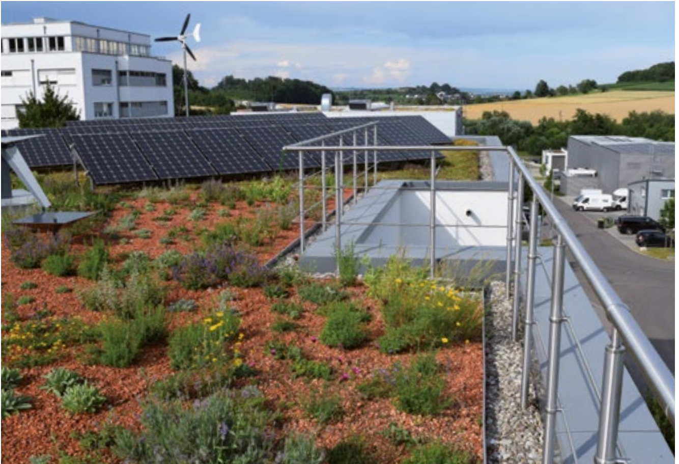
16 Dachgarten mit Intensivbegrünung und Absturzsicherung
